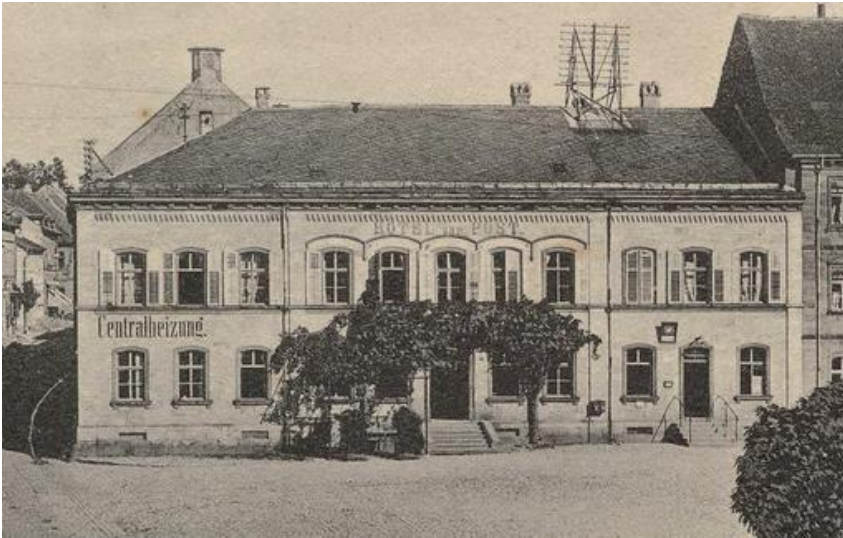
Gebäude im Maximilianstil östlich des Marktplatzes
