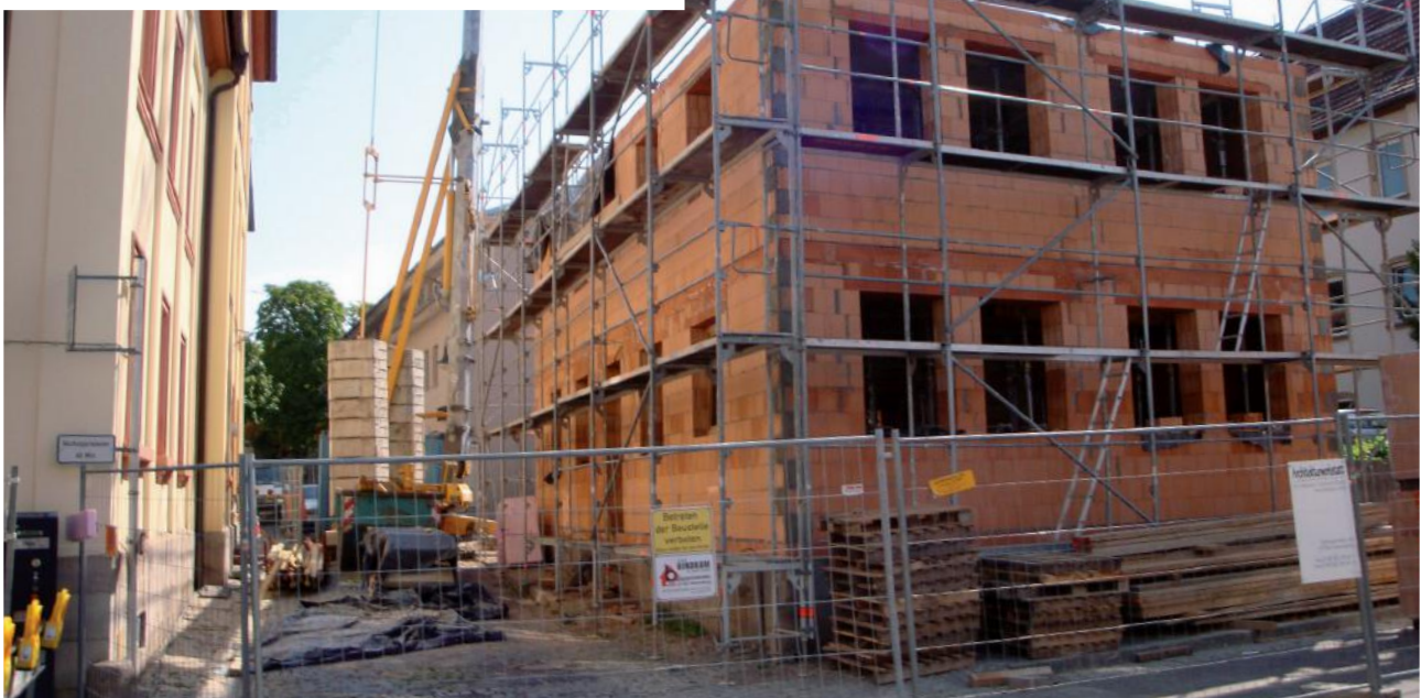
Bau- und Sanierungsarbeiten in der Bahnhofstraße
