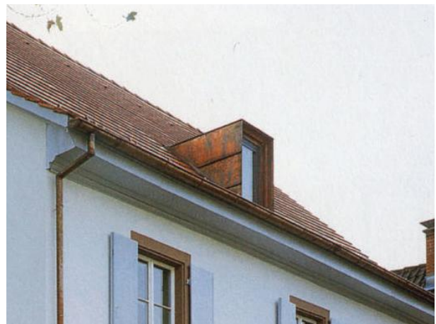
Zeitgenössische Dachgauben mit Kupferblech verkleidet
